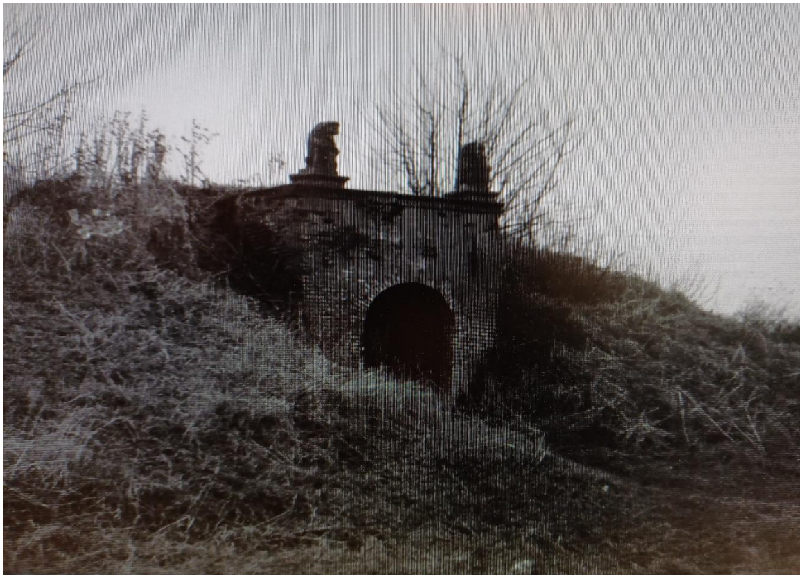
Foto van de restanten na de sloop van de toren en verdieping (HUA-beeldcollectie). De foto is gedateerd 1957 echter dat is niet waarschijnlijk.
