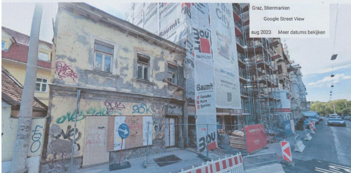
Afb. 21: Het huidige pand Lendkai 23 te Graz (google street-view).
